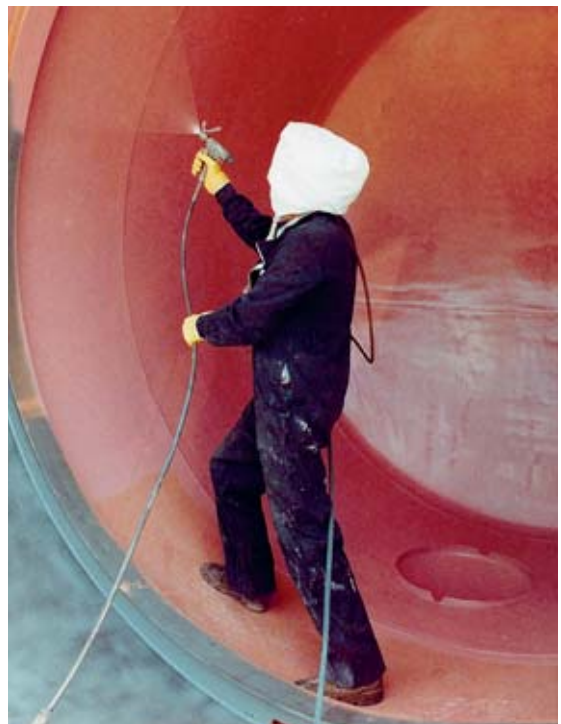
Bild 6: Epoxyharze sind eine häufige Ursache für Hautallergien. Bei grossflächiger Anwendung und v. a. bei Spritzarbeiten können Ekzeme auch durch Belastung der Umgebungsluft (Dämpfe, Aerosole) ausgelöst werden. Deshalb ist ein umfassender Hautschutz nötig.
